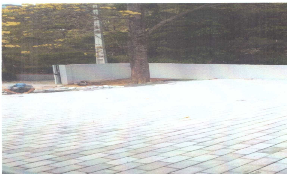
ASSENTAMENTO DE INTERTRAVADO
