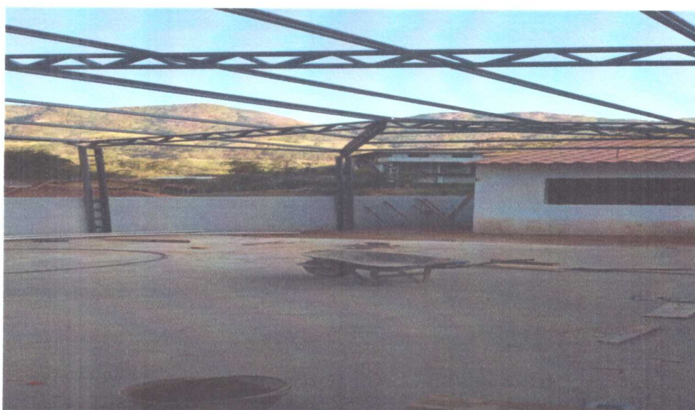
ESTRUTURA METÁLICA PARA COBERTURA
